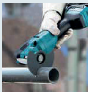
Corte de tubos de PVC
