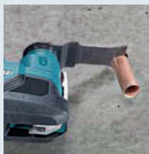
Corte a ras de tubos de cobre
