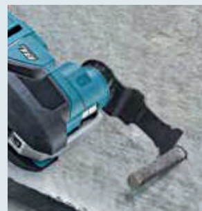
Corte a ras de barras de refuerzo
